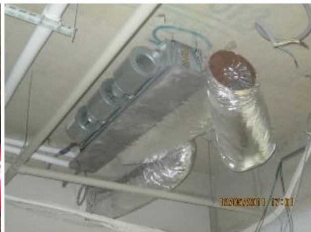
圖6.6 FCU空調系統風管機位於天板之構造樣式
