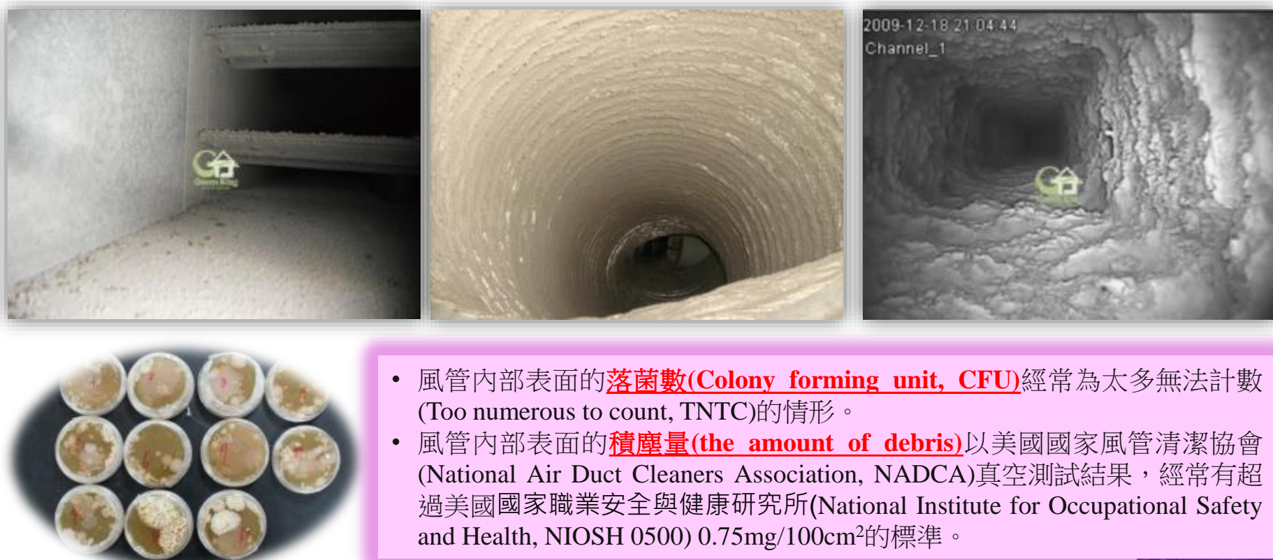
圖6.12 空調風管內容易藏污納垢之情形
