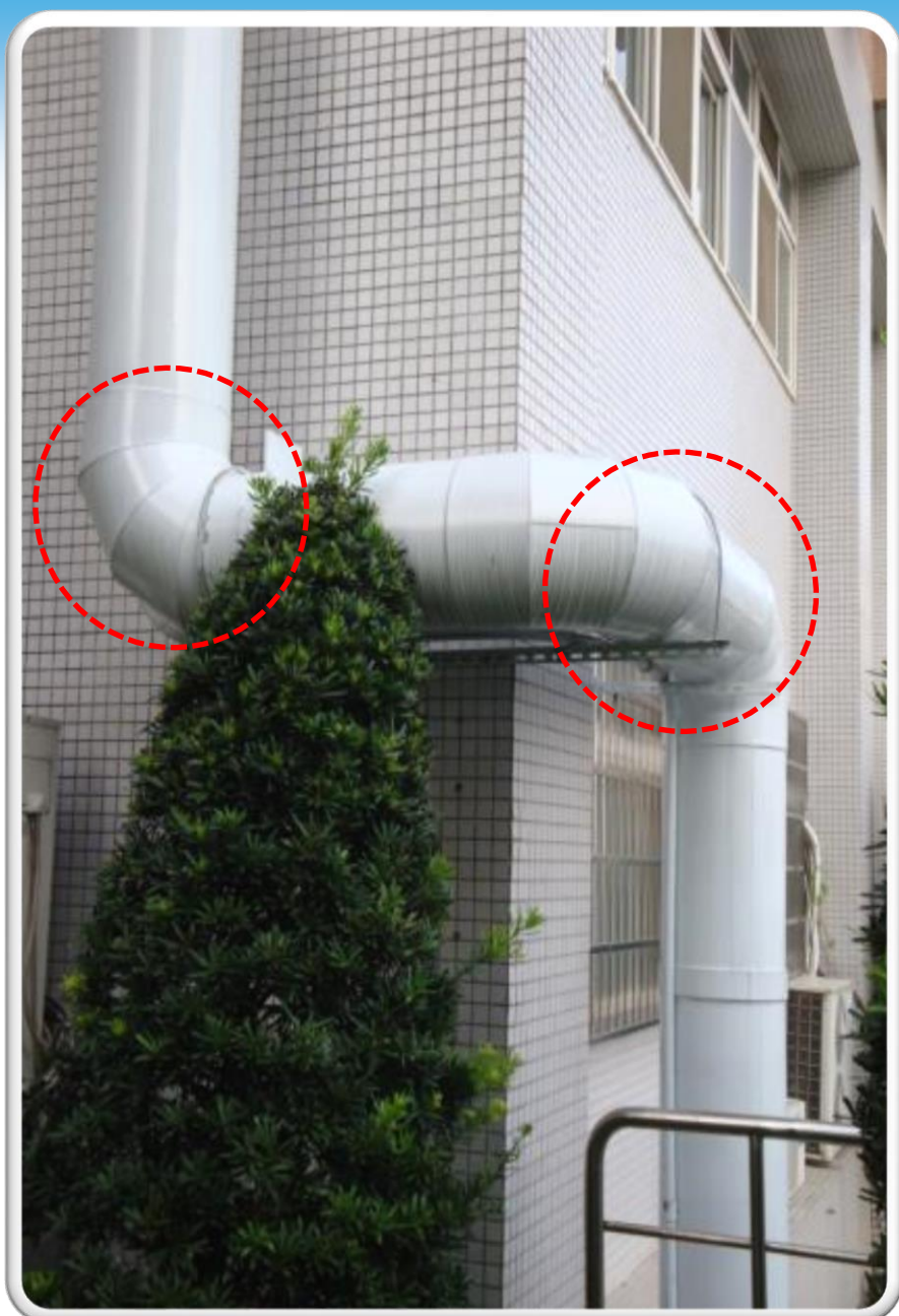
圖6.11 較佳(圓滑)的管線配置型態
