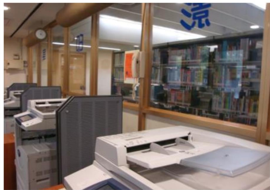
圖8.9 影印機獨立設置或採負壓排氣措施
