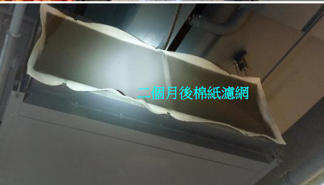
圖1.3 留意賣場（如家樂福）天花板懸吊空調箱的濾網狀況
