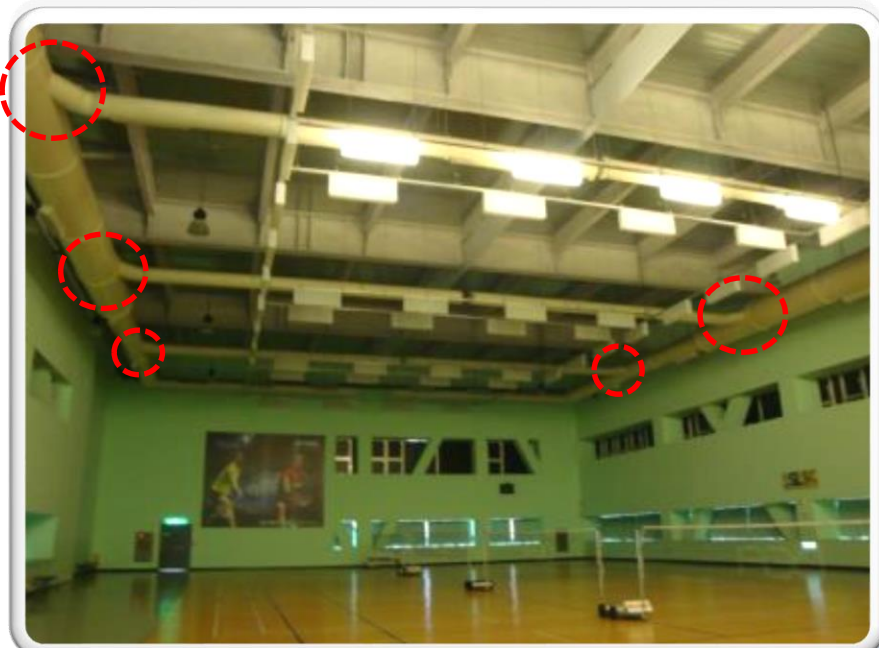
圖6.11 較佳(圓滑)的管線配置型態
