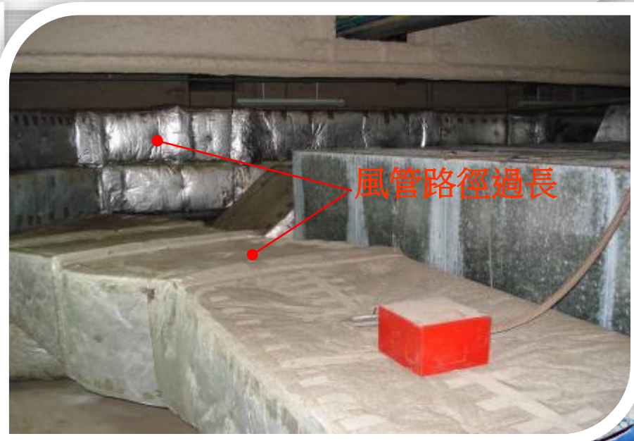
圖6.10 空調風管配置不當(90度急轉彎與扁平風管)
