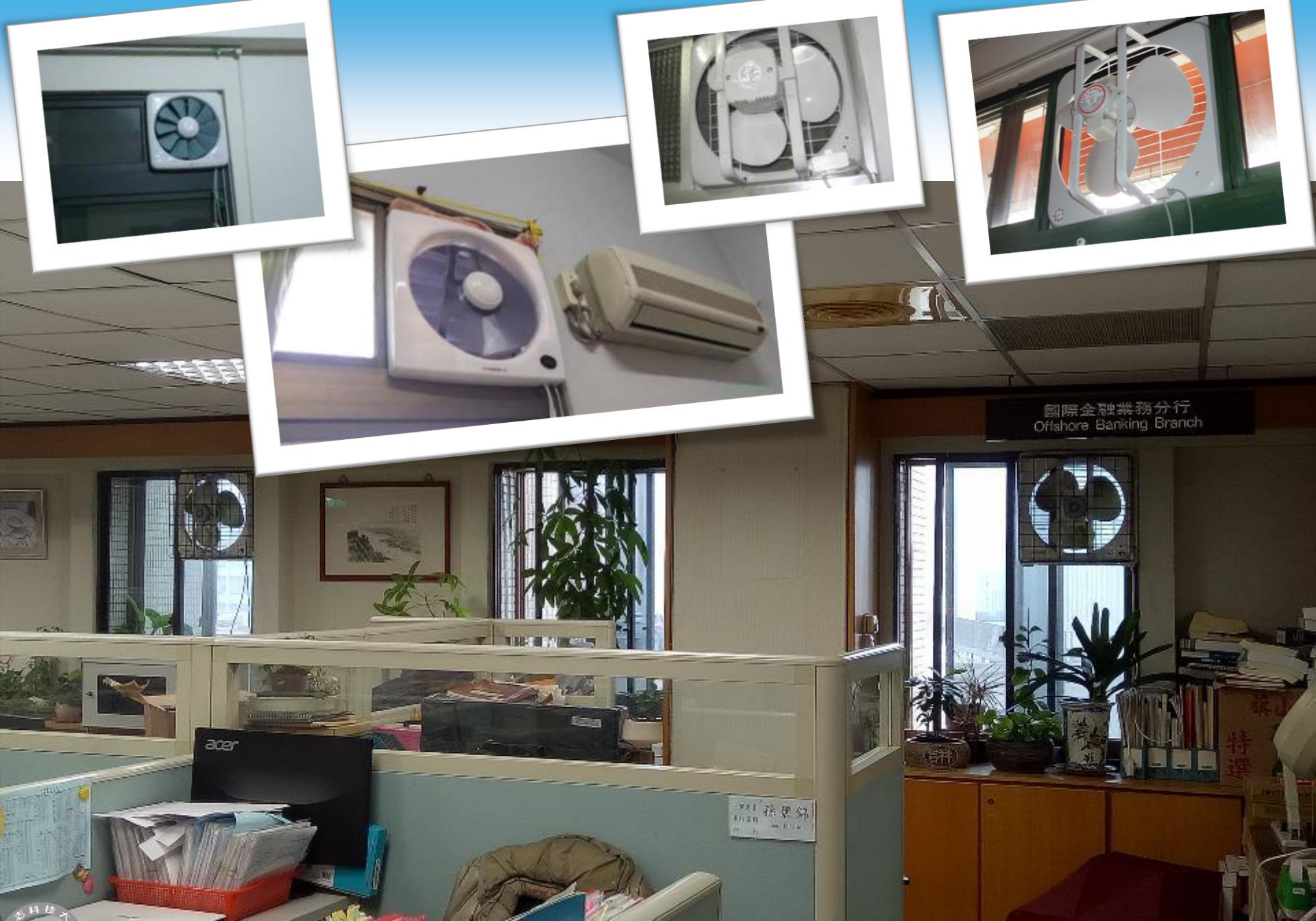
圖8.2 利用抽排風扇的簡易通風改善方式
