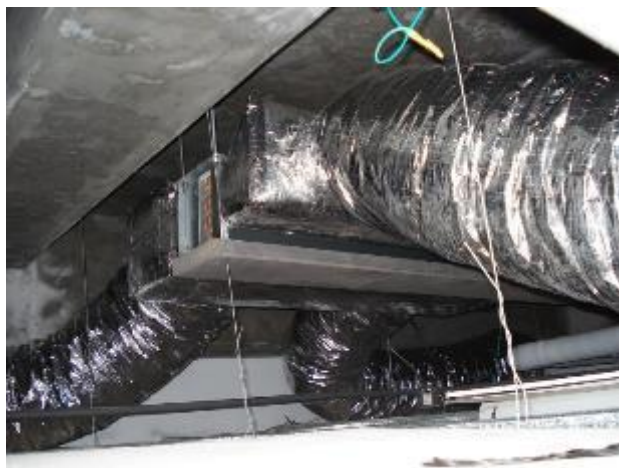
圖6.6 FCU空調系統風管機位於天板之構造樣式
