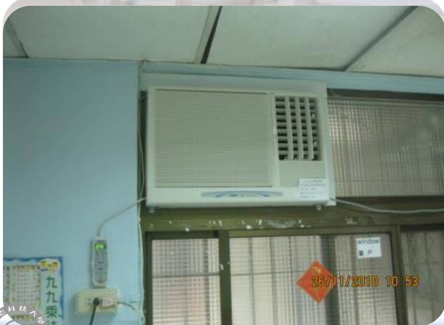
圖3.8 無外氣引入之內循環空調系統
