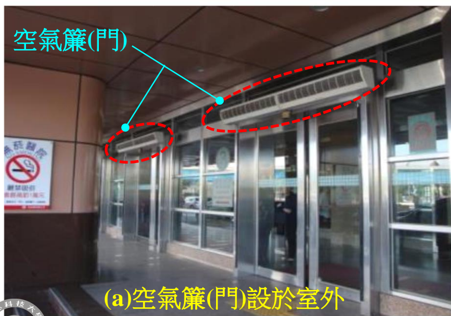
圖6.30 較佳的空氣簾(門)設置方式
