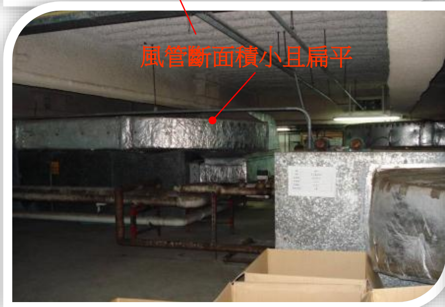
圖6.10 空調風管配置不當(90度急轉彎與扁平風管)
