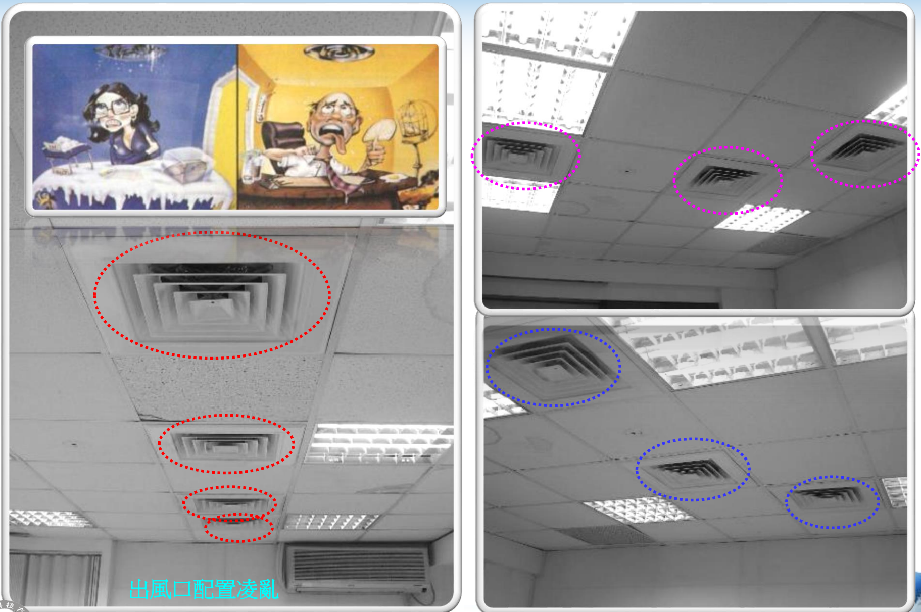
圖6.16 空調出、回風口配置位置與數量凌亂之情形
