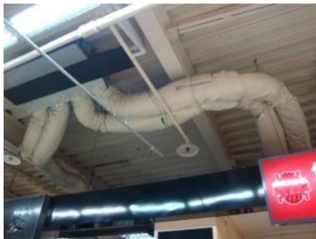
圖6.6 FCU空調系統風管機位於天板之構造樣式
