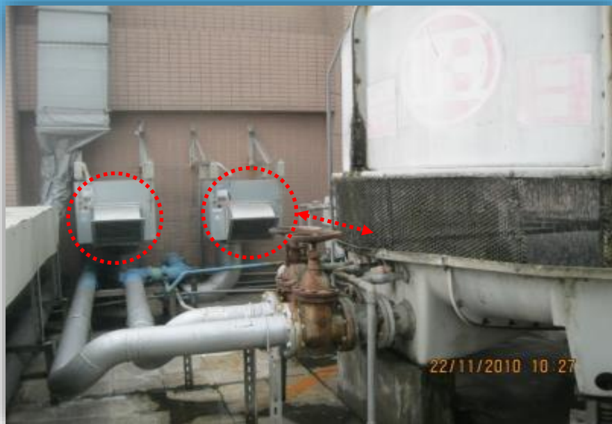
(a) 外氣引入口靠近冷卻水塔
