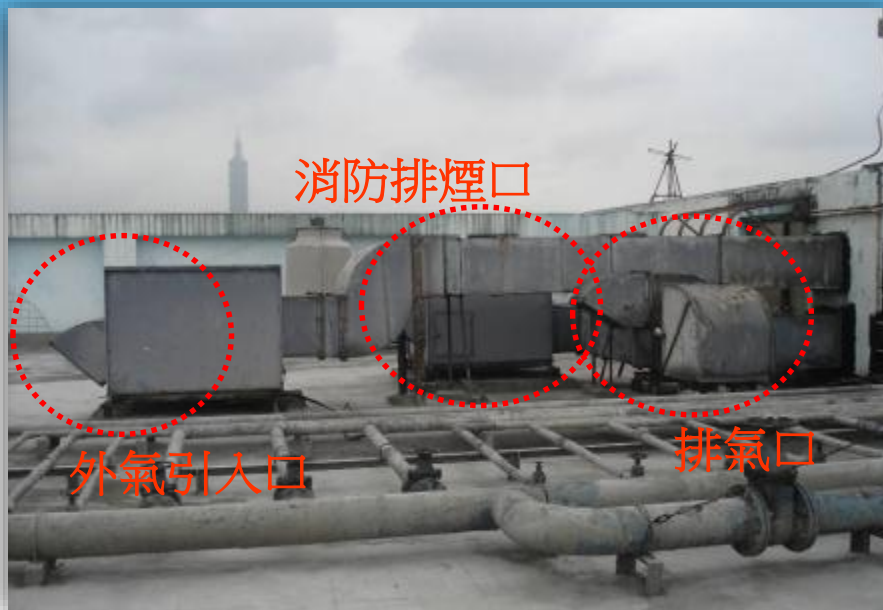
(b) 外氣引入口與排氣口近且同一方向
