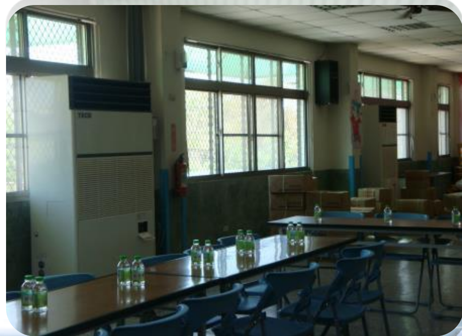
圖3.8 無外氣引入之內循環空調系統
