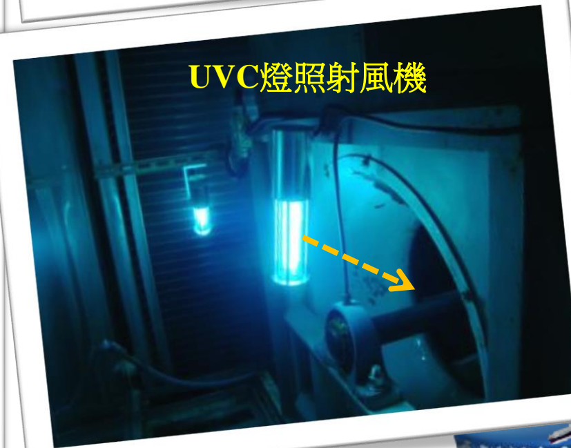
圖6.39 中央空調系統空調箱內UVGI淨化應用之實務案例
