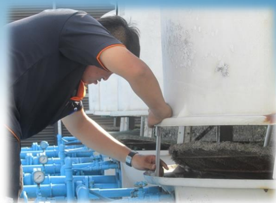
冷卻水塔防護網更換
