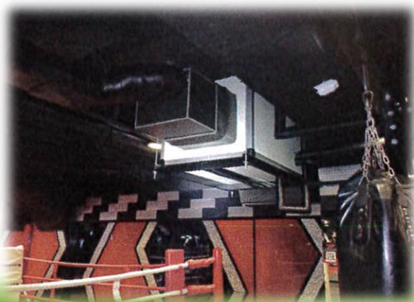
裝設預冷空調箱
