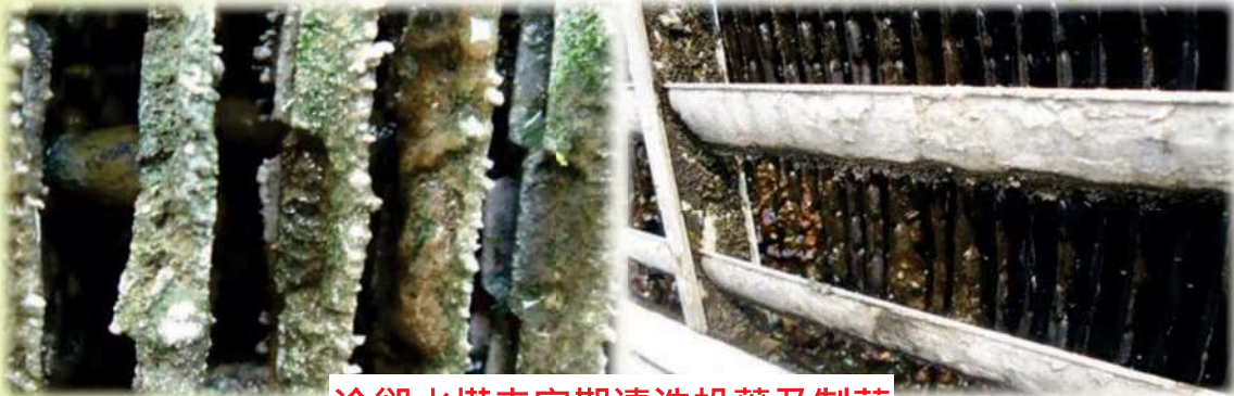
冷卻水塔未定期清洗投藥及制菌
