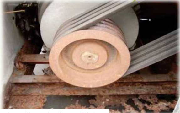
引入外氣口與管線生鏽、老舊且破損
