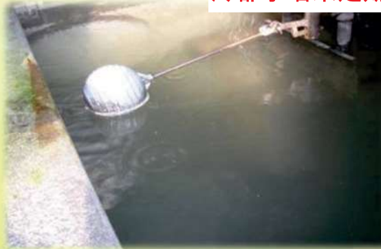
冷卻水塔未定期清洗投藥及制菌
