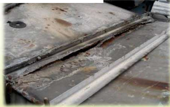
引入外氣口與管線生鏽、老舊且破損
