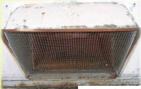
引入外氣口與管線生鏽、老舊且破損
