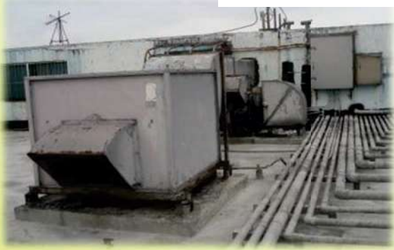
引入外氣口與管線生鏽、老舊且破損
