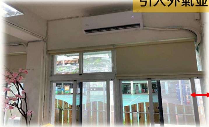
保留小縫隙開窗以適時 引入外氣並導出CO 2
